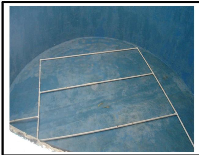
**Fig. 8. Tubería para la aireación de las postas de fijación.**
